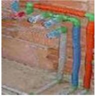
La fase lavorativa prevede la realizzazione della rete generale di distribuzione acqua fredda, posa tubazioni, colonne montanti di distribuzione di acqua fredda e calda ai singoli apparecchi del bagno, collettori di scarico dei singoli apparecchi sino alla colonna di scarico; montaggio degli apparecchi sanitari, rubinetterie, sifoni e pilette.
