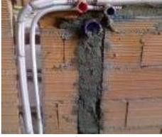
Realizzazione di un impianto sottotraccia, ossia di un impianto generalmente elettrico, telefonico, ecc., inserito nella muratura e non visibile all'esterno.
