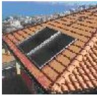
Realizzazione di un impianto solare termico su tetto a falde inclinate, in grado di sfruttare la radiazione solare per la produzione di acqua calda per usi igienico-sanitari domestici e per il riscaldamento degli ambienti, senza utilizzare gas o elettricità.
