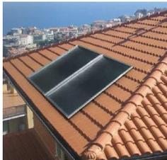
Posa in opera di collettore a piastra su tetto a falde inclinate. I collettori a piastra, sono composti da una cella/intelaiatura termicamente isolata (in legno incollato a tenuta di acqua o in alluminio), coperta da un vetro protettivo in grado di sopportare pioggia, grandine e temperature rigide, filtra i raggi solari e crea l'effetto serra per intrappolare il calore.
