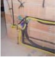
Trattasi della posa in opera delle tubazioni per le adduzioni del gas, collocate sotto traccia, rispettando i requisiti della norma di riferimento per gli impianti UNI CIG 7129/08. Le tubazioni sotto traccia possono essere installate nelle strutture in muratura (pavimenti, pareti perimetrali, tramezze fisse, solaio) purché vengano posate con andamento rettilineo verticale ed orizzontale. La fase prevede l'esecuzione delle seguenti operazioni:
