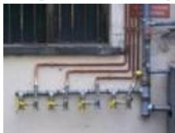
Trattasi della posa in opera delle tubazioni per le adduzioni del gas sulle pareti esterne di un fabbricato, che, secondo la norma di riferimento per gli impianti UNI CIG 7129/08, non possono essere posate sotto traccia nel lato esterno dei muri perimetrali in quanto costituiscono parte comune dell'edificio. Devono, invece, essere installate a vista oppure per ridurre
