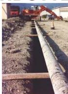
Trattasi della movimentazione e posa in opera di tubazioni in acciaio negli scavi predisposti e nella esecuzione delle saldature di assemblaggio dei vari elementi.
