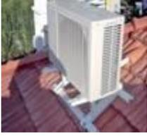
Trattasi dell'installazione dell'unità esterna del condizionatore sulle falde di un tetto, mediante l'utilizzo di staffe regolabili che, posate sulla superficie inclinata a disposizione, consentano comunque l'installazione a livello dell'apparecchio. Le staffe devono essere vincolate alla superficie sulla quale sono posate, senza danneggiare l'impermeabilizzazione della superficie stessa, sia che essa sia realizzata mediante tegole che con una guaina catramata.
