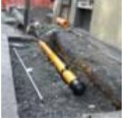
L'attività prevede la posa in opera delle tubazioni per le adduzioni del gas in percorsi esterni ed interrati, nel rispetto dei requisiti della norma di riferimento per gli impianti UNI CIG 7129/08. Le tubazioni interrate devono essere provviste di un adeguato rivestimento protettivo contro la corrosione ed isolate, mediante giunti dielettrici, da collocarsi fuori terra, nella immediata prossimità delle risalite della tubazione. La fase prevede l'esecuzione delle seguenti operazioni:
