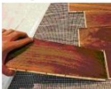
Trattasi della posa in opera di listoni di parquet predefinito di grosse dimensioni, sistemati su un sottile strato di materiale isolante acustico posizionato su massetto livellato oppure su pavimento preesistente. Il fissaggio delle tavole di legno avviene mediante un incastro che segue la combinazione maschio-femmina.
