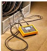
In questa fase, gli elettricisti procedono alla verifica di tutti gli impianti realizzati al fine di controllare che gli stessi risultino idonei per l'utilizzazione prevista (in sostanza si verifica che la tensione arrivi in tutti i punti alimentati e che i collegamenti rispondano alle potenzialità ed usi previsti).
