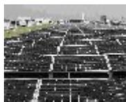
Realizzazione di un impianto solare termico su tetto di copertura piano o a terrazzo, in grado di sfruttare la radiazione solare per la produzione di acqua calda per usi igienico-sanitari domestici e per il riscaldamento degli ambienti, senza utilizzare gas o elettricità.
