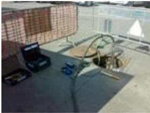
Trattasi dell' esecuzione di prove di tenuta ad aria ed acqua dei giunti tra tubi pesanti oppure flessibili, finalizzata alla verifica della tenuta idraulica della condotta e dei manufatti oggetto del rilievo, ovvero all'individuazione di eventuali perdite.
