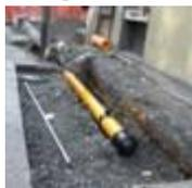
Trattasi della posa in opera delle tubazioni per le adduzioni del gas, che possono essere collocate a vista, sotto traccia, interrate, in strutture appositamente realizzate, in guaina, rispettando i requisiti della norma di riferimento per gli impianti UNI CIG 7129/08. Le tubazioni, in funzione della loro collocazione, possono essere in ferro zincato, rame e polietilene multistrato.
