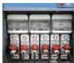
Connessione dell'impianto di utenza alla rete di distribuzione dell'energia elettrica. E' realizzato dal distributore locale con la posa della presa (l'impianto che collega il contatore alla rete di distribuzione) e del contatore.
