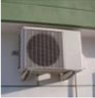
Trattasi dell'installazione dell'unità esterna del condizionatore sulla facciata dell'edificio, senza incidere sulla statica e sull'estetica del fabbricato.
